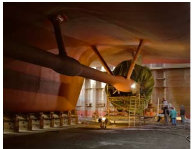
M/S Visby i torrdocka i samband med roderbyte. Bilden visar propellerhylsan, propellern övertäckt för målning samt övre delen av det nya roderhornet.
